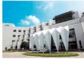
台南研發中心 (鑽石級綠建築)
